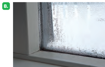
B. Parte de uma janela com água acumulada.
